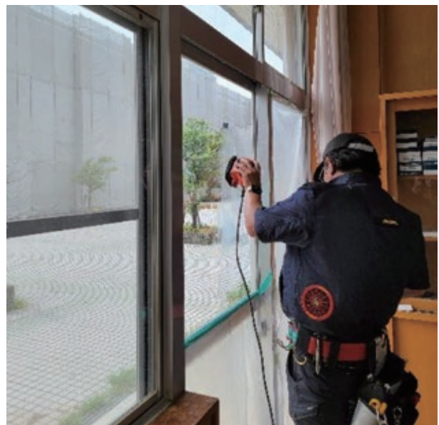
上は中学校の教室に採用された時の工事写真です。
